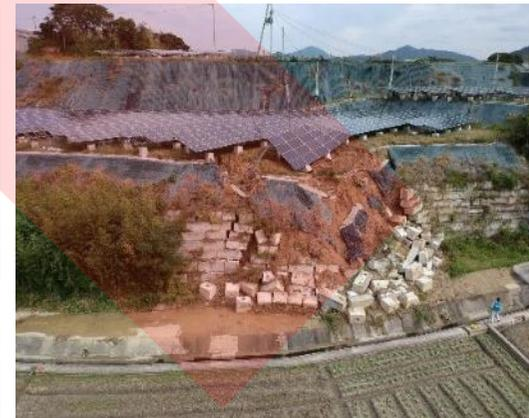
法面保護工が崩れて流出した事例
