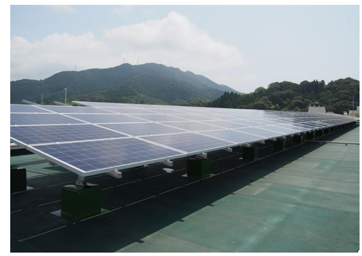
旧小学校屋上
