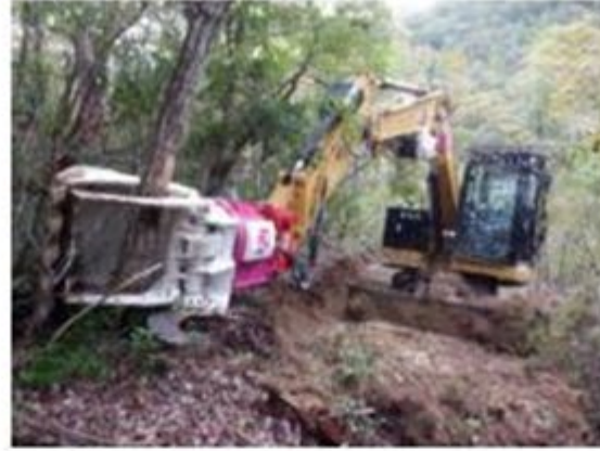
支障木の伐採
