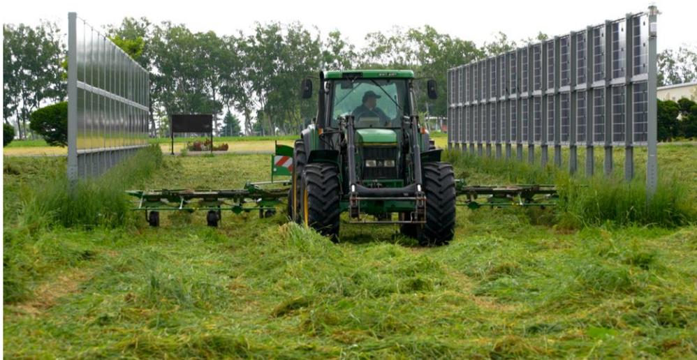
酪農学園大学と自然電力は、垂直式太陽光発電を積雪地域の牧草地に設置することで、牧草の生育に必要な日射量を確保しながら、太陽光発電を行う実証実験を行っています。これにより、牧草地の有効利用と再生可能エネルギーの普及を同時に促進することを目指します。温室効果ガスを排出しない再生可能エネルギーの創出を通じて、持続可能な農業の実現に貢献します。
