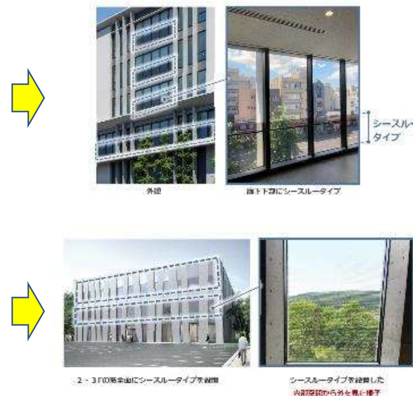
新築建物へのBIPVの導入事例
