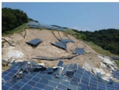
土砂崩れで生じた崩落
