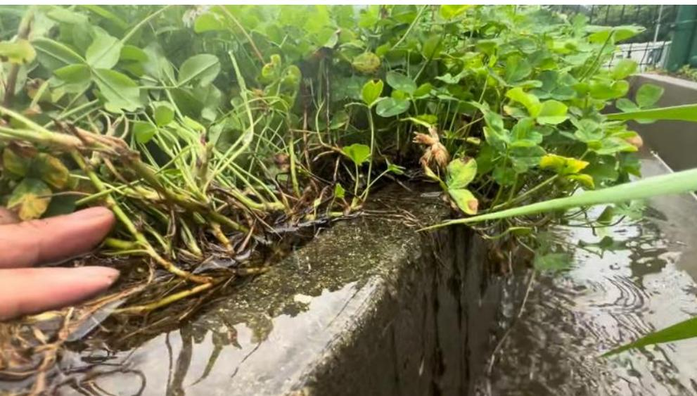
雨水の殆どが雑草をつたうようにU字溝に流れ込んでいき砂は流れ出していない。
