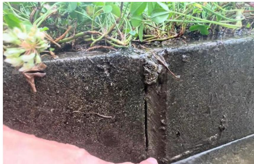
U字溝のつなぎ目部分の隙間からも透明な雨水が流れ出てくる
