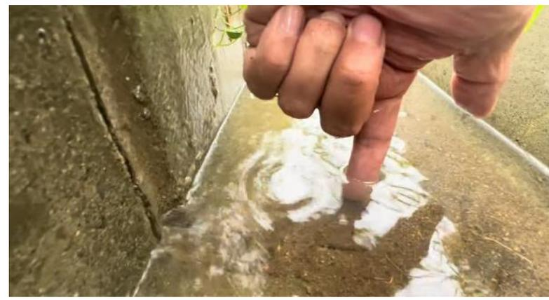
かなり強い雨が降ったのち、小雨になった状態で排水溝内部の状態を確認した。排水は透明で水深2cm程度。
