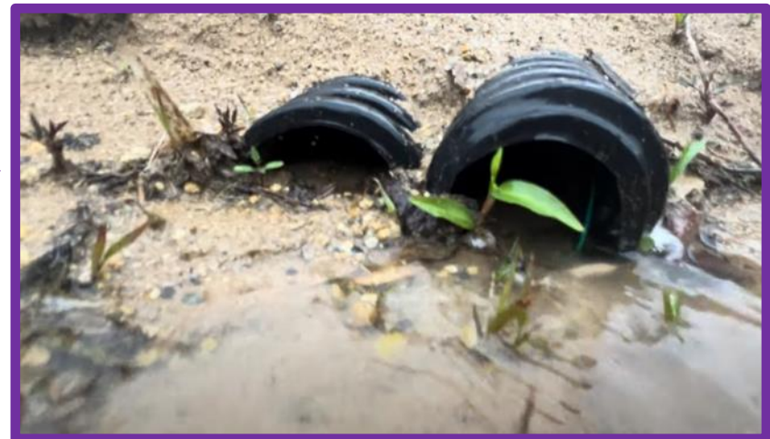
排水ダクトを2本埋設 ※ 9か月後の状態
