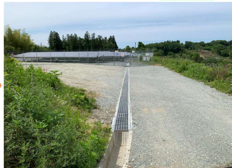
③発電所内全域雨水排水改修 After
