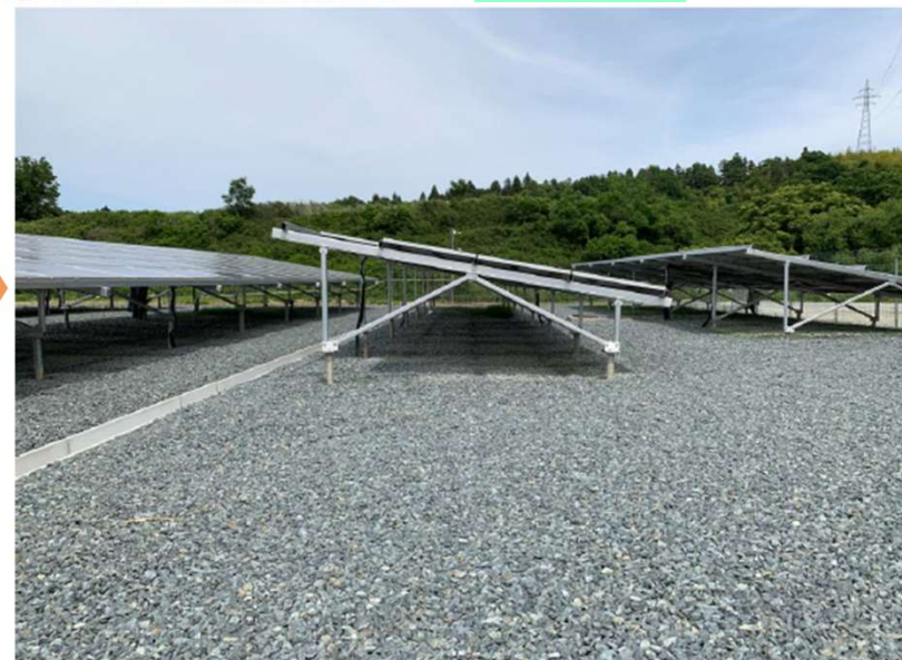
①東西U字溝新設是正 After
