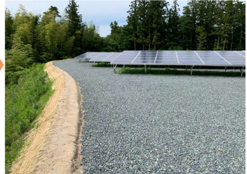
④堰堤の再形成・法面植生 After
