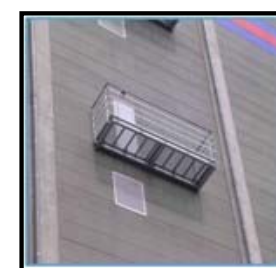
②非常用進入口
